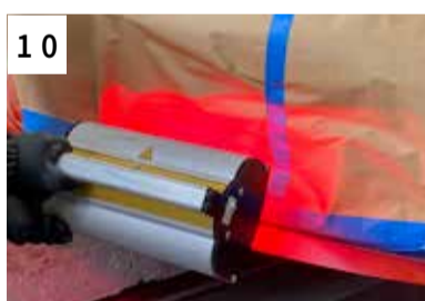
10 IR Trocknung, ca 15 Min bei 40 cm Abstand
